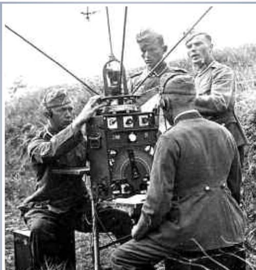
Полевой пеленгатор на базе приёмника EP-2a.
