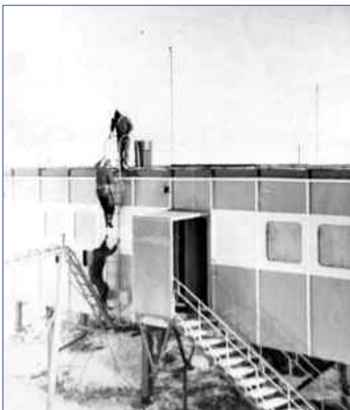
Ремонт вертикала 4К1А на помещении приёмного радицентра.
