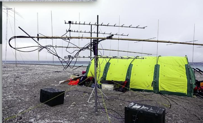
Монтаж УКВ-антенн.
