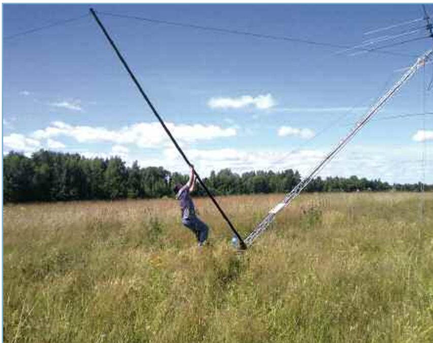
Ответственный этап — подъём мачты с установленной антенной и поворотным устройством.
