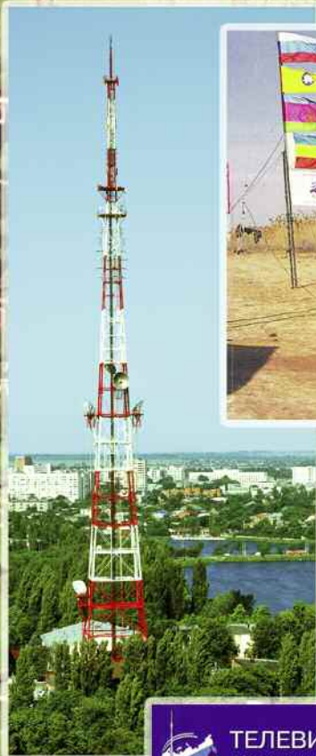
▼ Радиотелевизионная передающая станция г. Краснодара.
