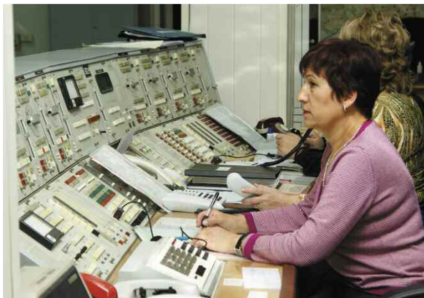
Центральная аппаратная московской станции проводного вещания.
